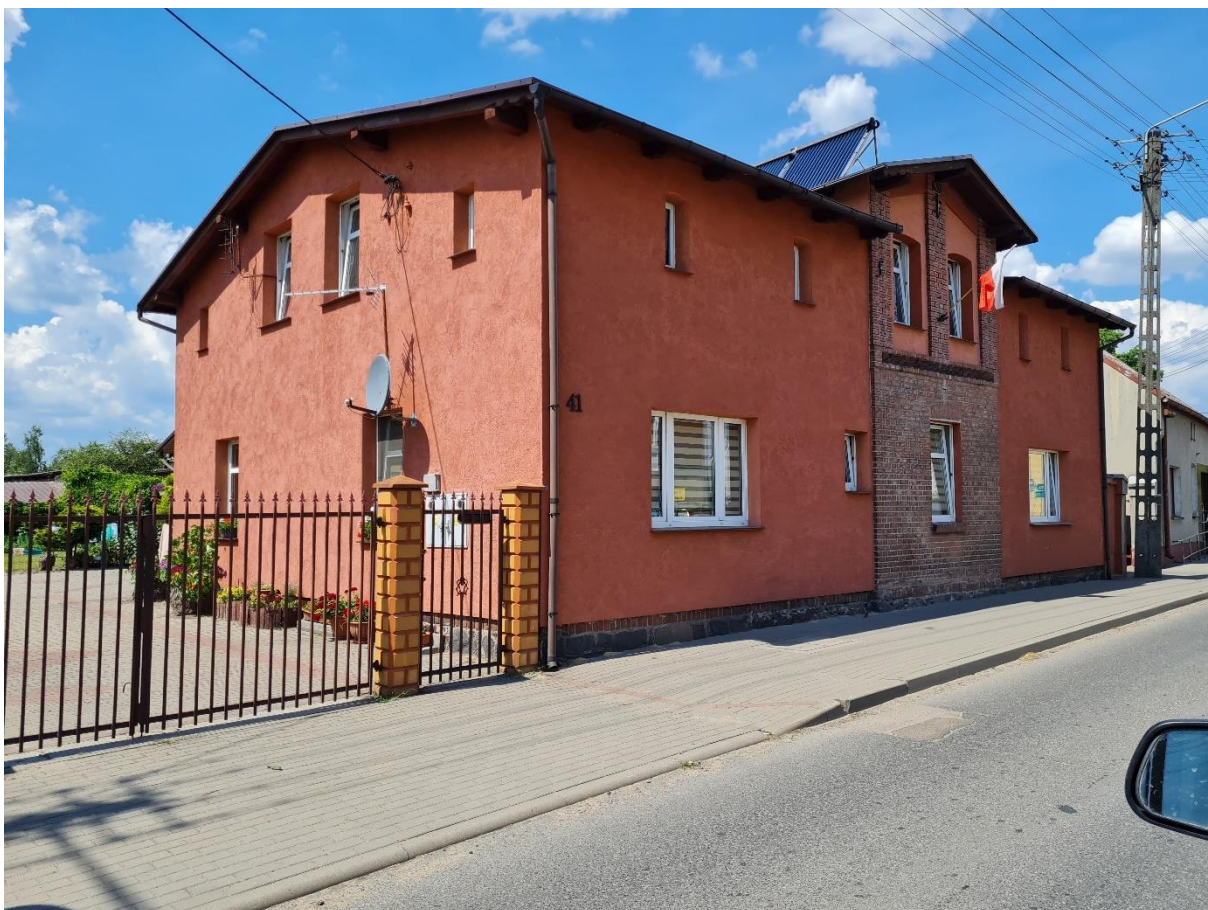
Fot. 7. Dom mieszkalny zlokalizowany przy ul. Głównej 35 ujęty w Gminnej Ewidencji Zabytków
