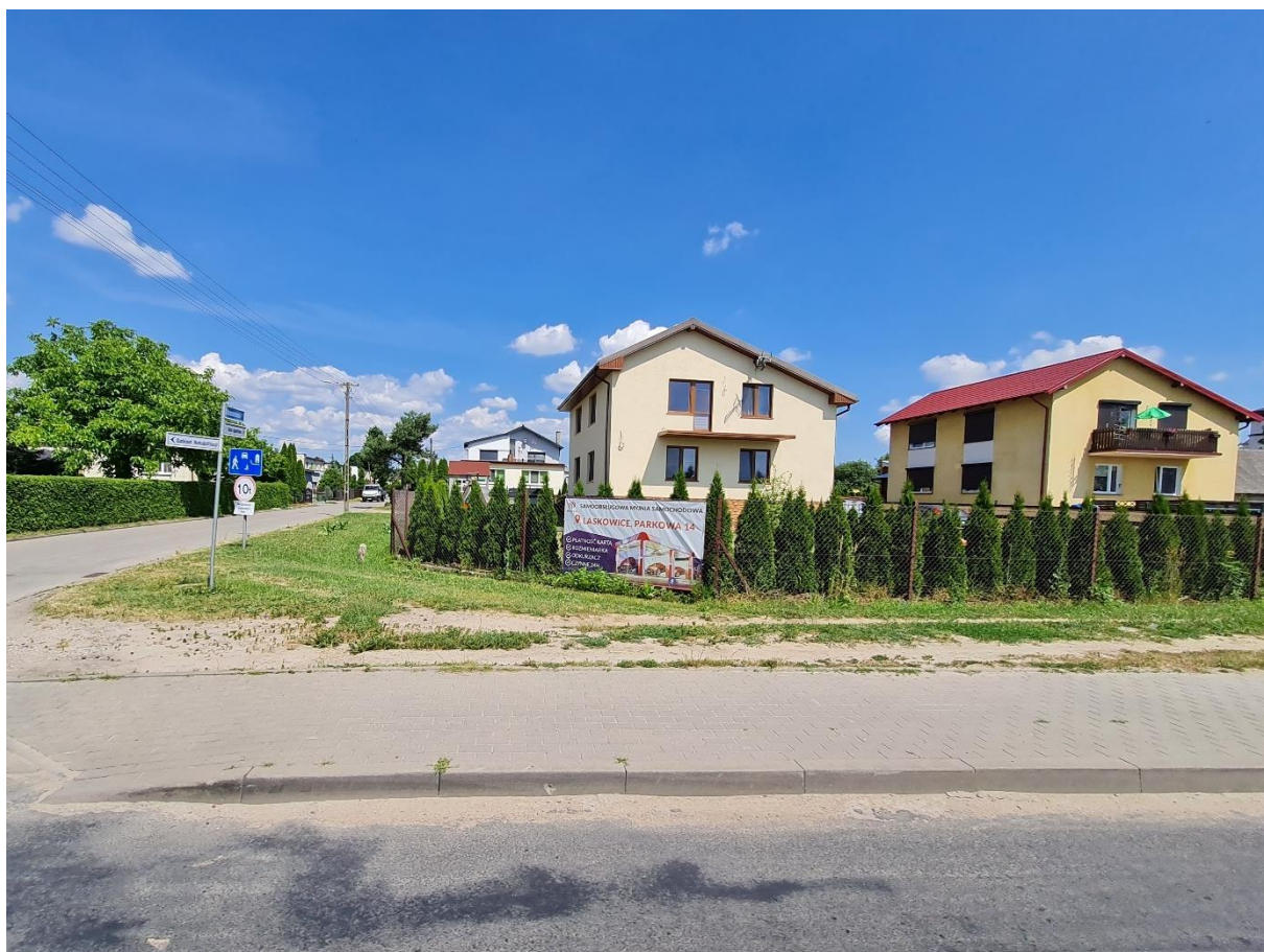
Fot. 3. Zabudowa mieszkaniowa jednorodzinna zlokalizowana przy ul. Laskowickiej we wschodniej części obszaru
