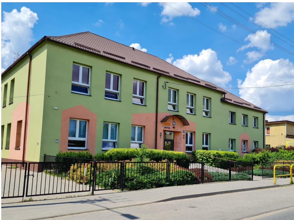
Fot. 5. Budynek Szkoły Podstawowej im. Adama Mickiewicza w Jeżewie (widok od strony ul. Główniej)
