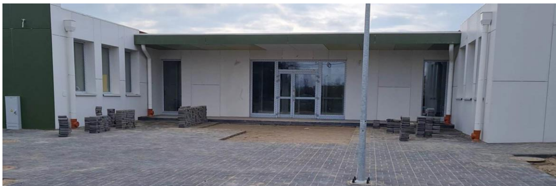
Główna siedziba Centrum Biblioteki i Kultury w Gminie Jeżewo w trakcie modernizacji (ul. Mickiewicza 3a, Laskowice)
