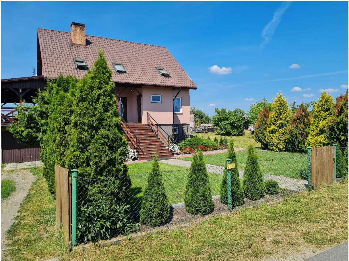
Fotografia 14. Zabudowa mieszkaniowa zlokalizowana przy ul. Polnej w centralnej części obszaru
