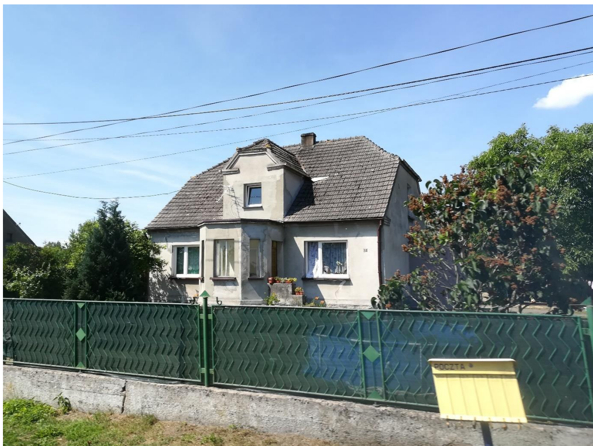
Fotografia 7. Zabudowa mieszkaniowa zlokalizowana przy ul. Parkowej w południowej części obszaru
