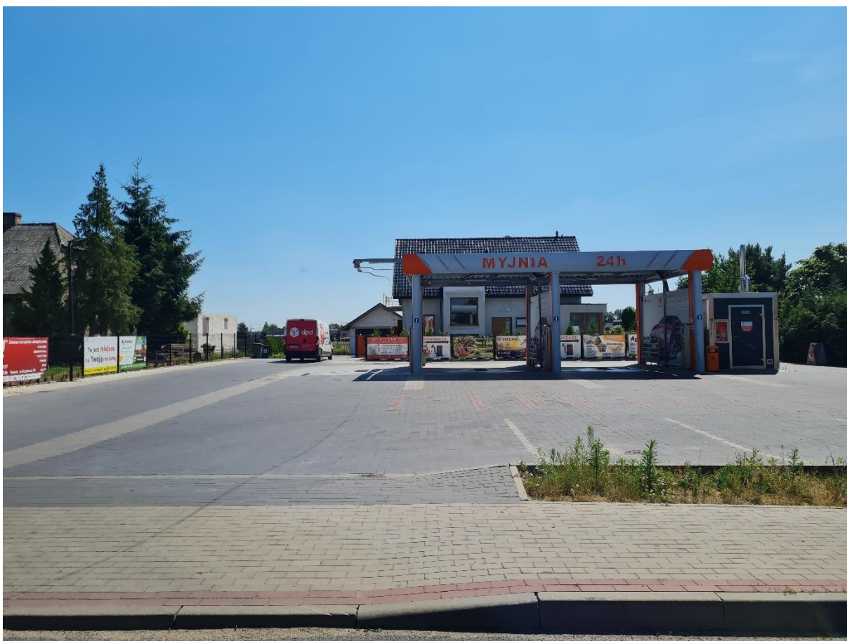
Fotografia 6. Widok na myjnię samochodową zlokalizowaną przy ul. Parkowej w południowej części obszaru
