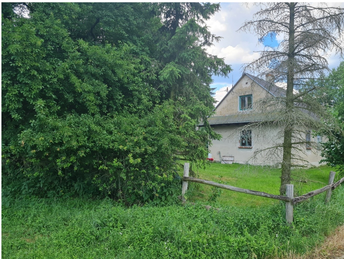
Fotografia 6. Zabudowa mieszkaniowa jednorodzinna zlokalizowana w północnej części obszaru
