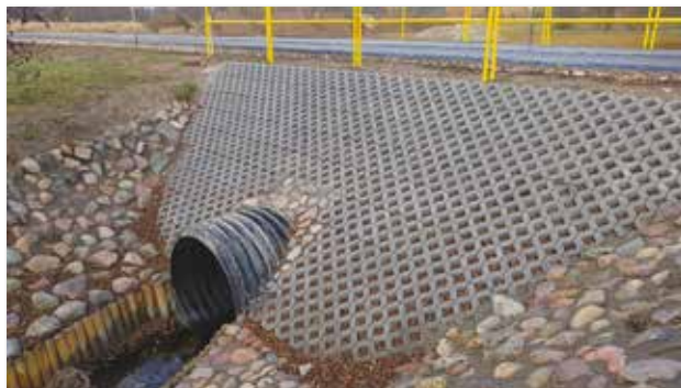
Przepust w Ciemnikach
