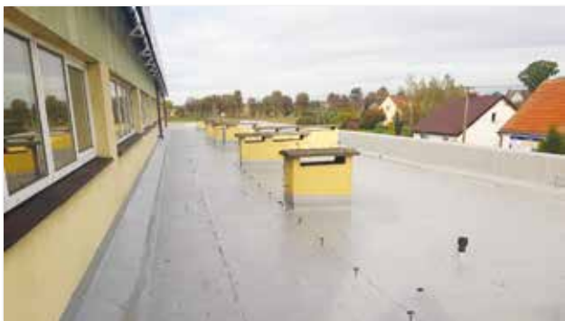
Nowy dach na hali sportowej w Jeżewie
