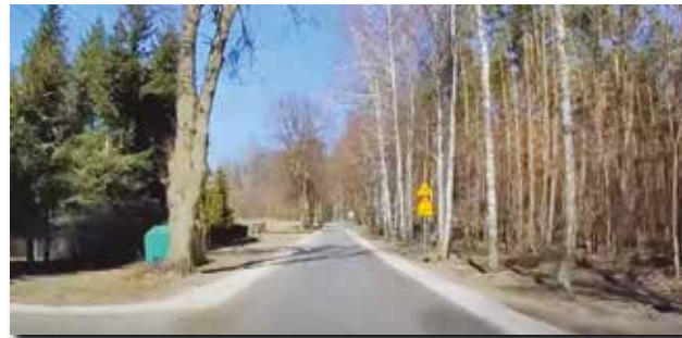
Ulice Dębową i Kolejową w Jeżewie
